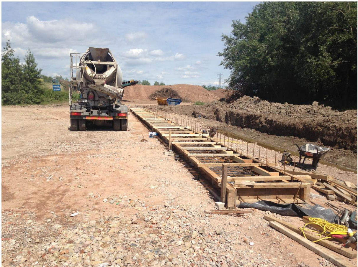
Shuttering for first concrete pour
