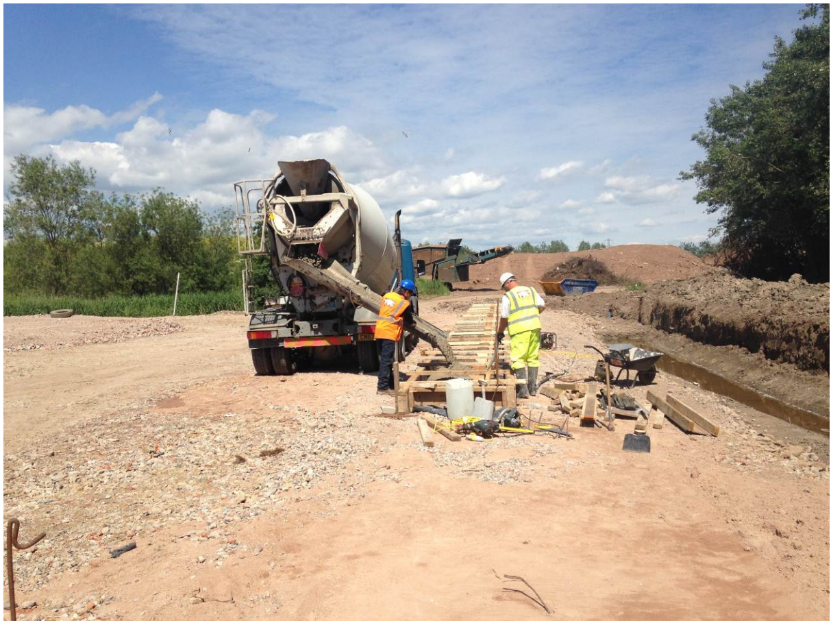
First concrete pour
