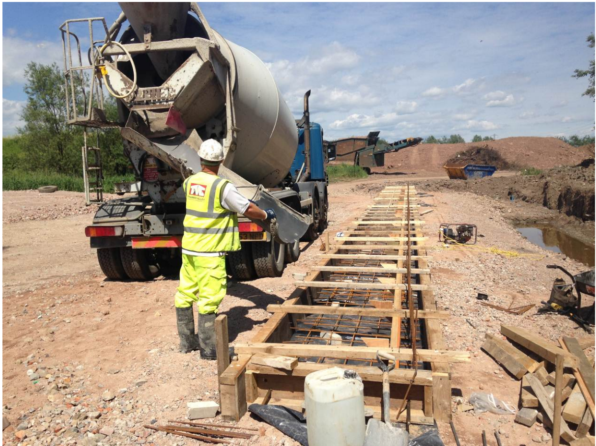
First concrete pour
