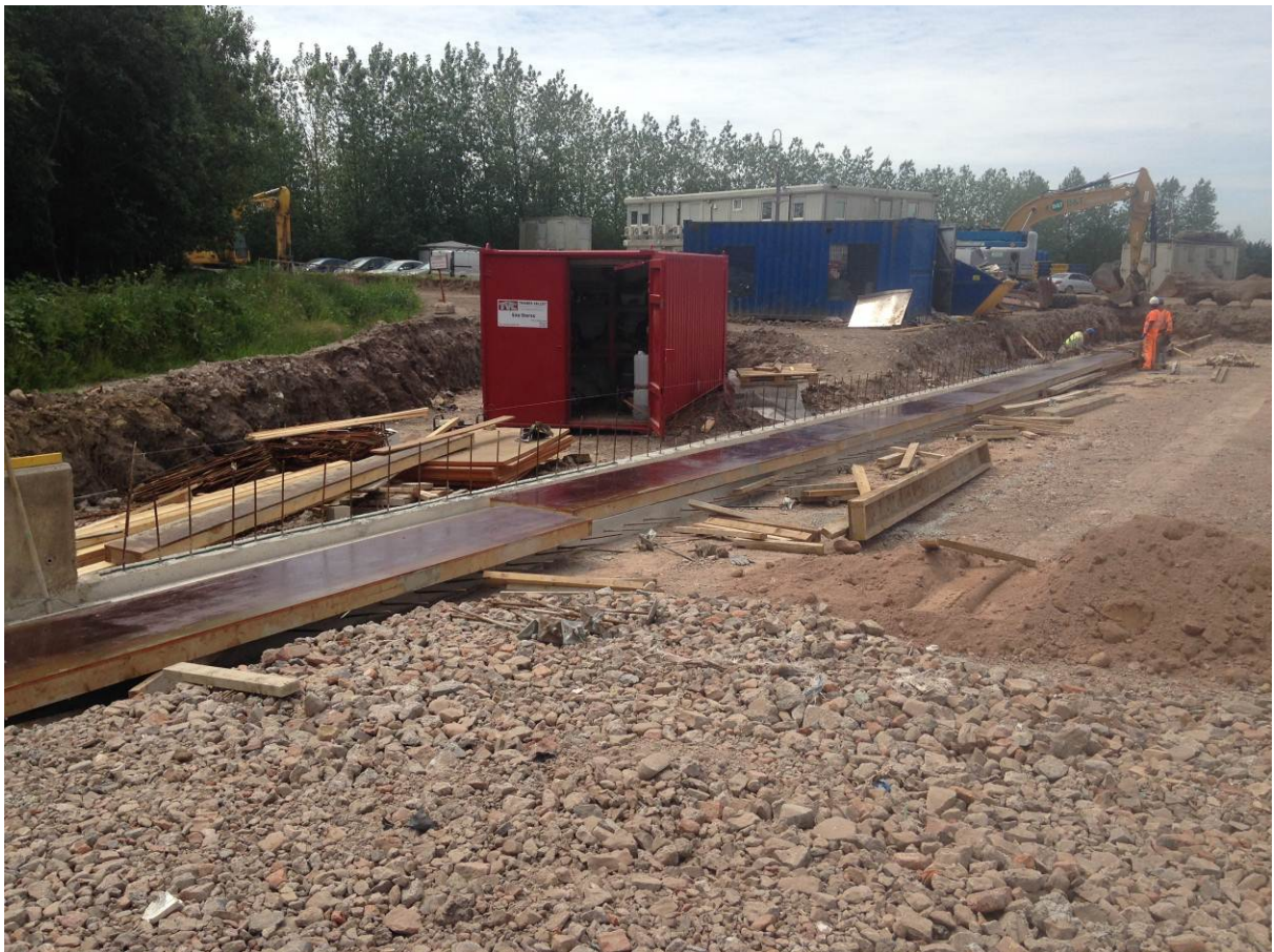
Preparation for headwall pour
