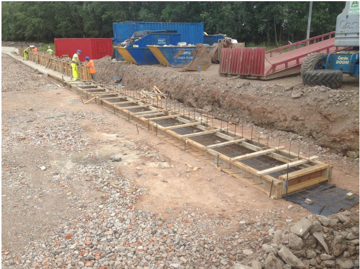
Shuttering for final concrete channel pour
