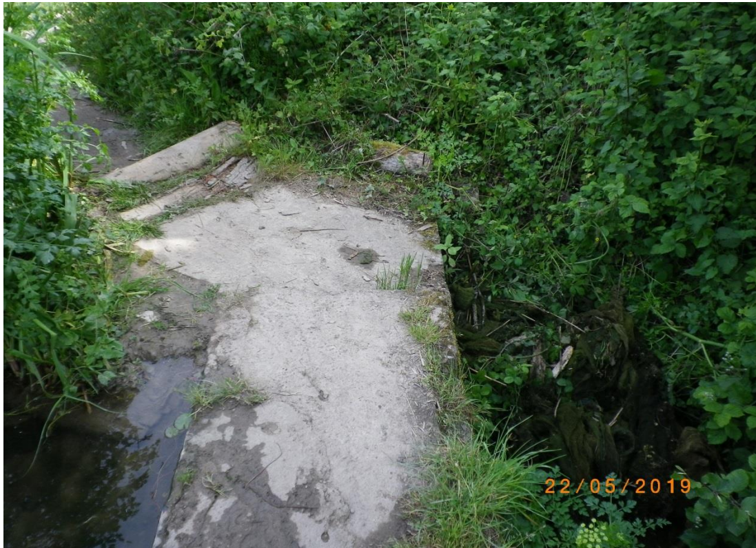
Sunken side slab
