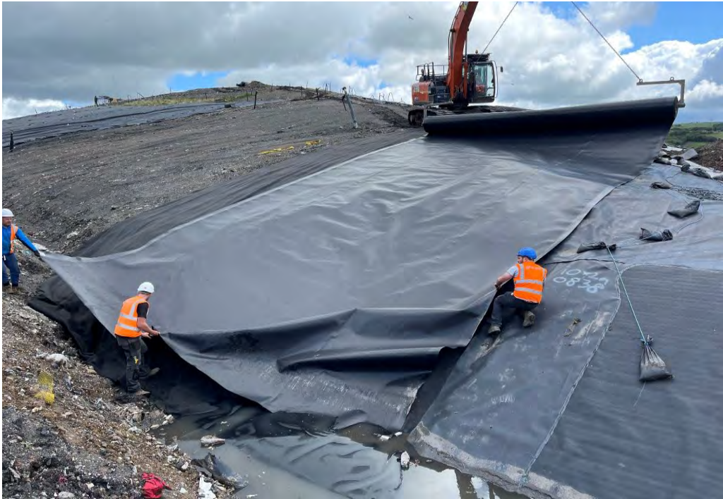
Installing Geomembrane
