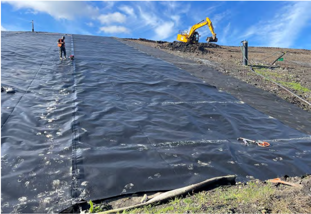
Fusion Welding Geomembrane
