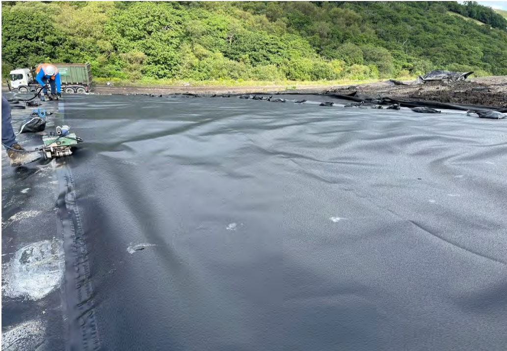
Fusion Welding Geomembrane
