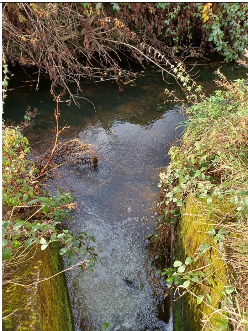
Image 4: Final effluent discharge point
