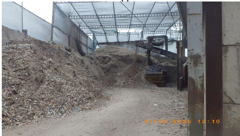
Trommel fines area
