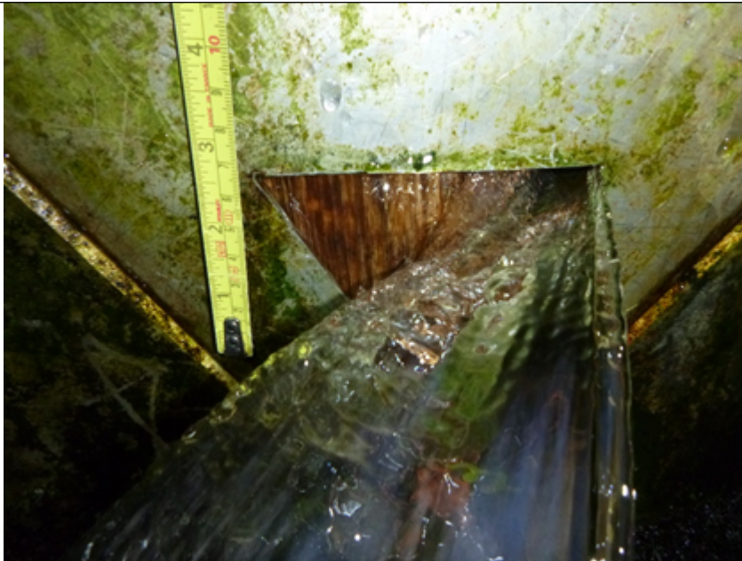
Llun 2. Pibell osgoi'r gwaith tynnu dŵr wedi'i rhwystro. Image 2. Abstraction bypass blocked.
