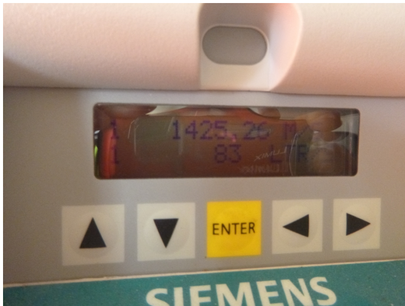
Figure 2. Meter at Llyn Teifi.
